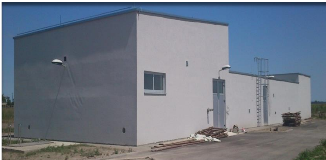
Slika 5 - Pogled na izgrađenu zgradu UPOV-a Kneževi Vinogradi
