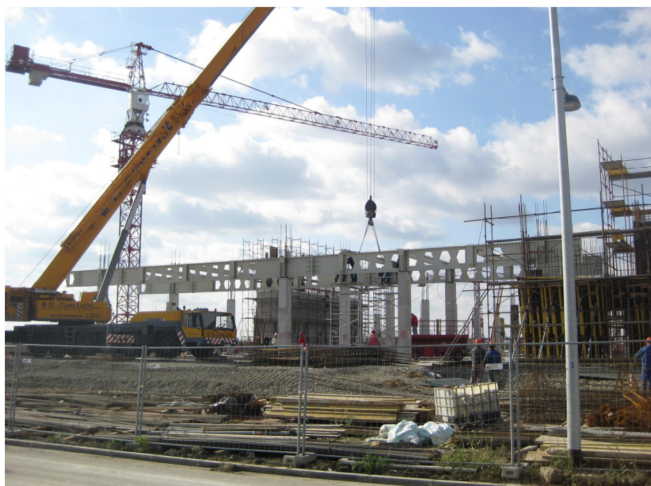
Slika 15 – Montaža glavnog sačastog nosača
