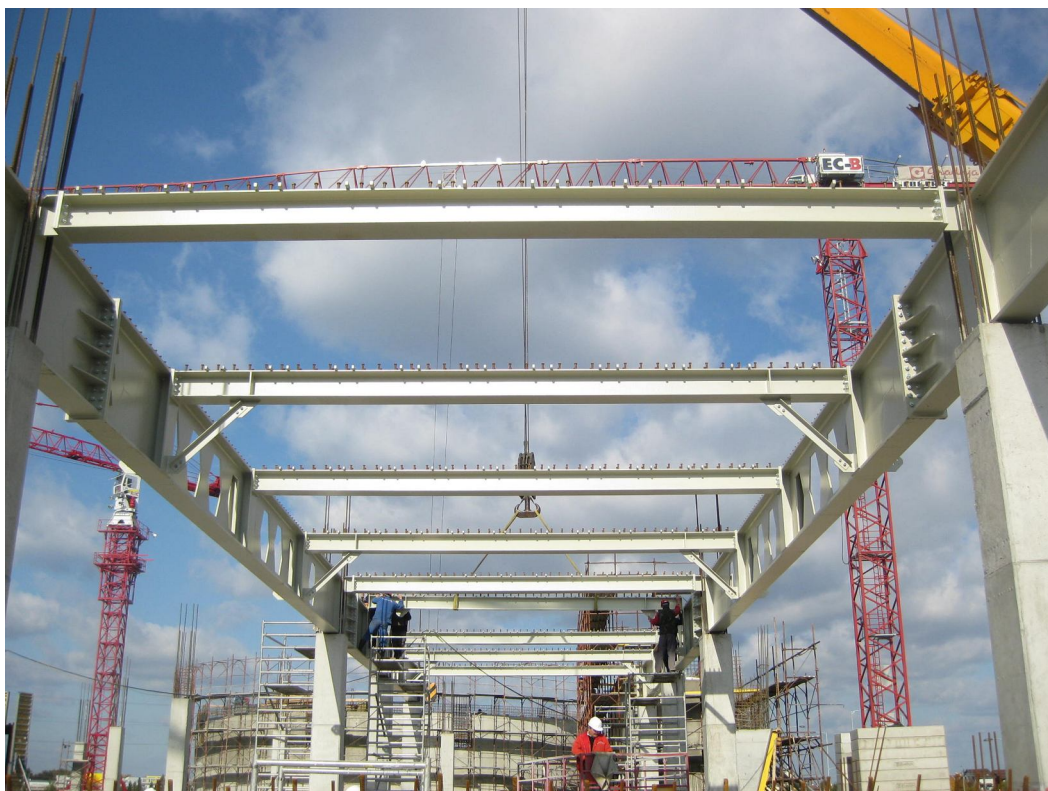
Slika 16 – Montaža sekundarnog nosača
