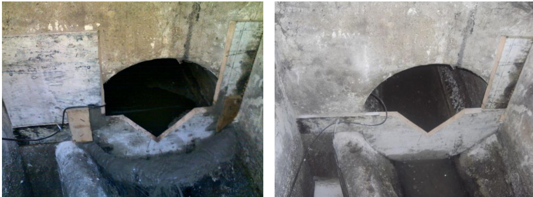
Slika 7 - Postavljanje, učvršćivanje i brtvljenje preljeva
