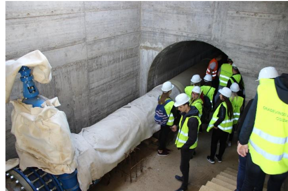
Strojarnica crpne stanice Dvor (Bobotski kanal - Vuka); Kešinci - kontrolno okno i zatvarač temeljnog ispusta;
