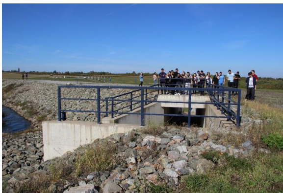
Bočni preljev i propust kroz nasutu branu Koritnjak; Brana Švajcerija - ulazna građevina (preljev i ispust);
