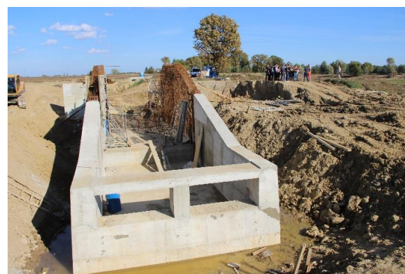
Bočni preljev i propust kroz nasutu branu Koritnjak; Brana Švajcerija - ulazna građevina (preljev i ispust);
