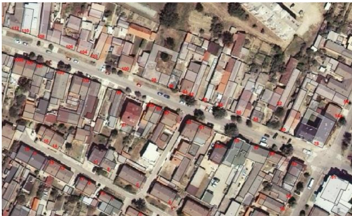
Lokacija izgradnje kanalizacije
