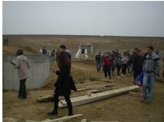
Radovi na glavnim vodograđevine višenamjenske akumulacije Čitluk
