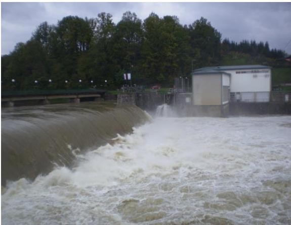
Noviji objekti HE Ozalj 2 iz 1952. godine s dva agregata (Kaplan turbine) od po 1,1 MW i betonska preljevna brana visine 9,2 m
