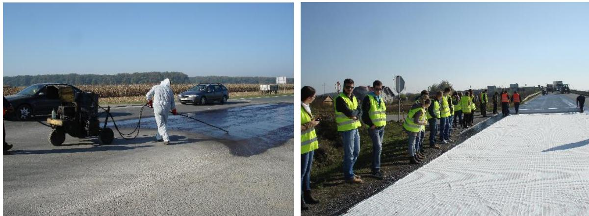
Priprema kolnika sastojala se od frezanja postojećeg asfalta te ravnomernog špricanja bitumenske emulzije polimer bitumenom u svrhu osiguranja boljeg prianjanja mreže.
