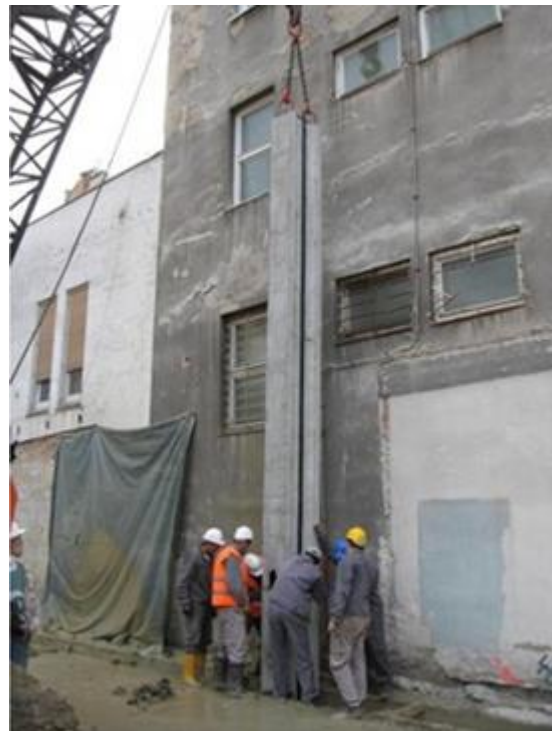
Slika 2 – Ugradnja rubnih elemenata s Waterstop trakom u iskopani element dijafragme
