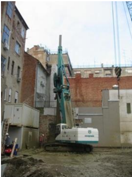
Slika 1 – Iskop ugaonog elementa dijafragme
