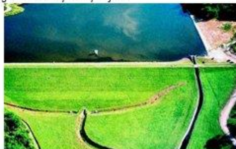
Izvedba brzotoka evakuacijskih objekata brane Seginac i uređenje korita potoka
